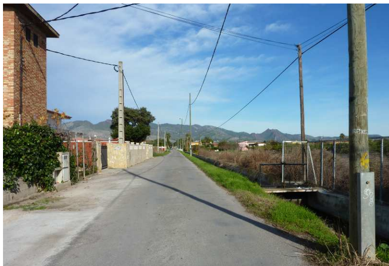
Ubicación del contador eléctrico de alumbrado en la zona centro del Camino 1ª Travessera
